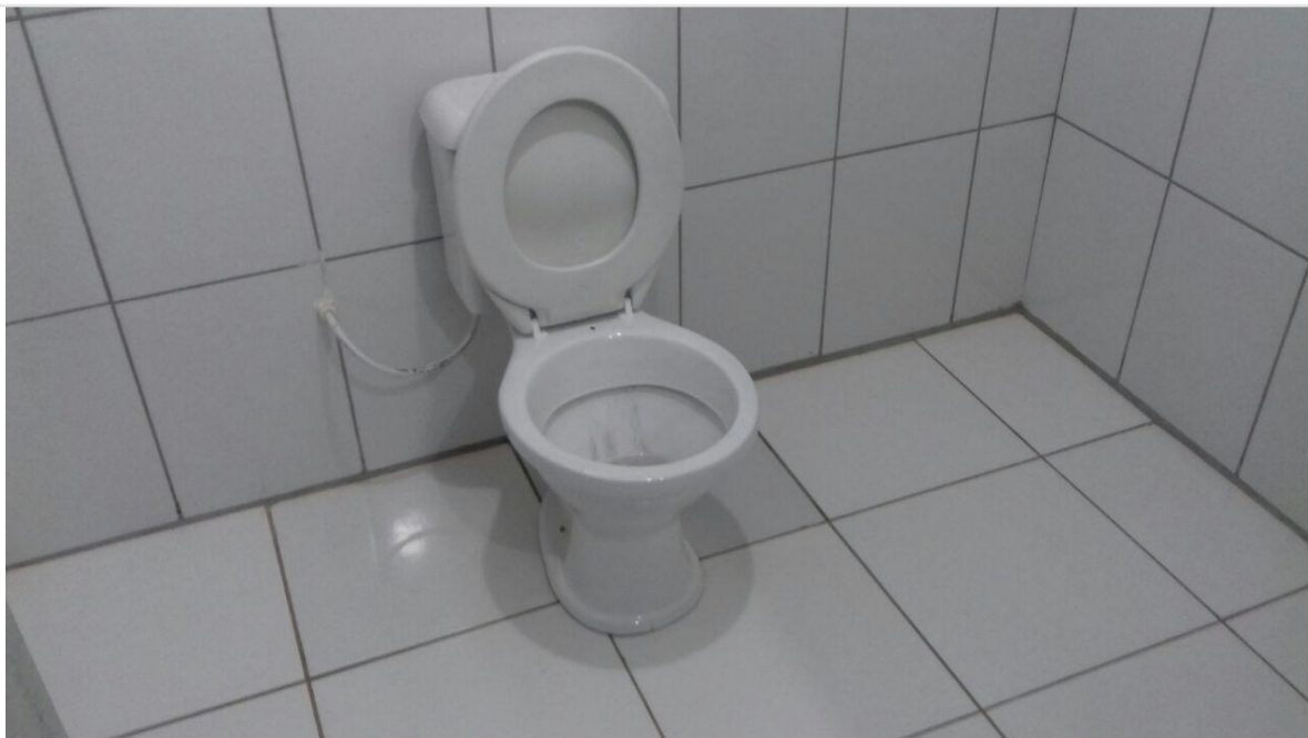
Internas da obra concluída Data da última atualização: 21/06/2017
