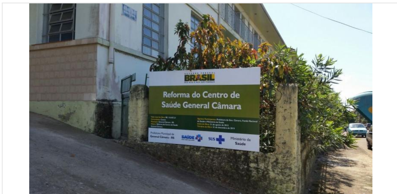
Placa da obra Data da última atualização: 23/09/2015
