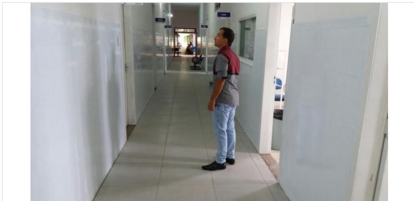
Internas da obra concluída Data da última atualização: 21/06/2017
