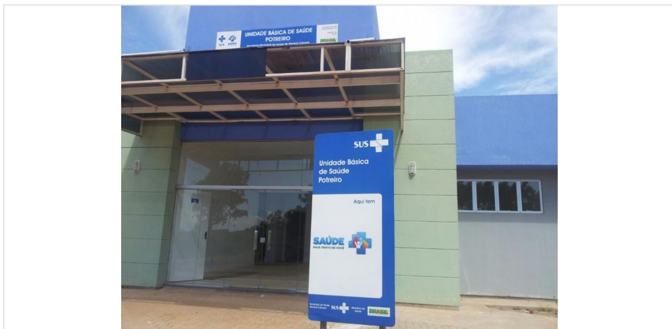
Fachada Data da última atualização: 03/02/2015
