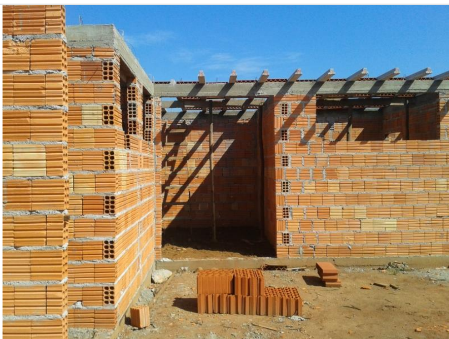
Fotografia da 2ª etapa de execução Data da última atualização: 18/02/2014
