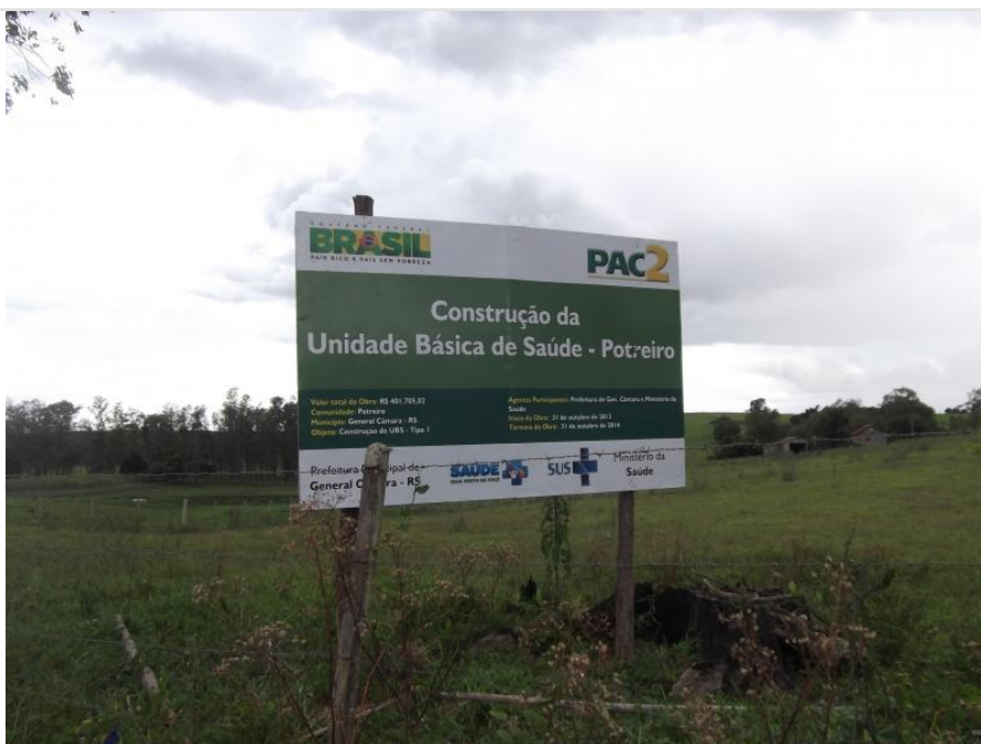
Placa da obra Data da última atualização: 25/11/2013
