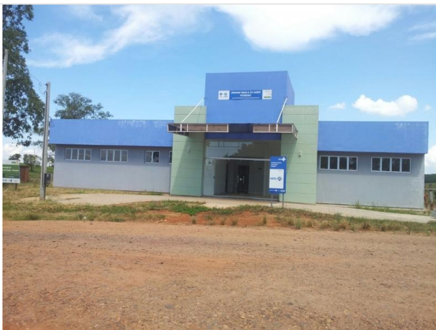
Fachada Data da última atualização: 03/02/2015
