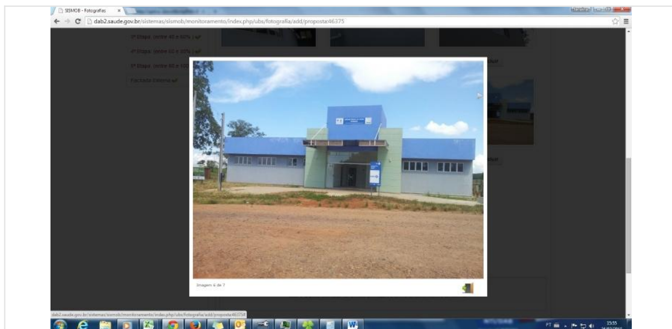
Fachada Data da última atualização: 24/02/2015
