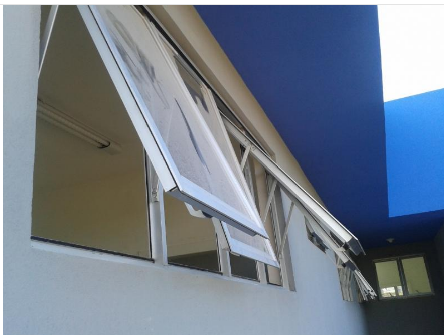
Fachada Data da última atualização: 16/07/2014
