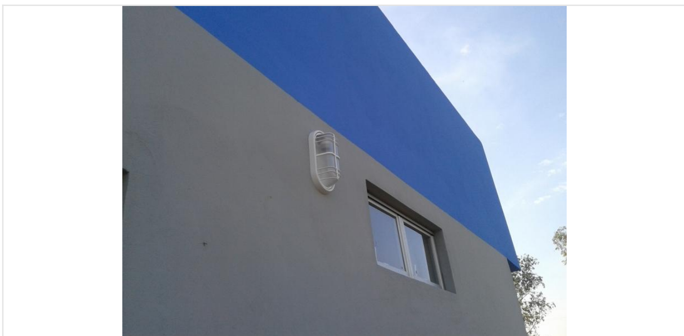
Fachada Data da última atualização: 16/07/2014
