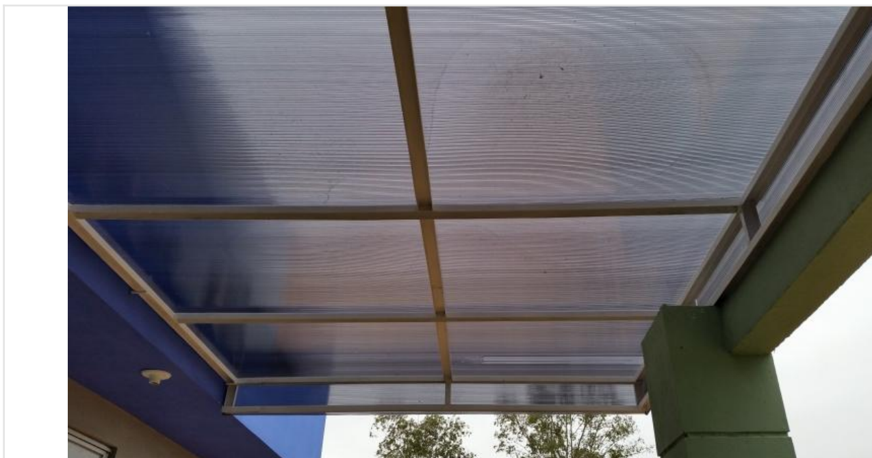
Fachada Data da última atualização: 11/08/2014
