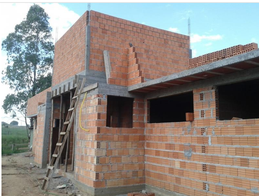
Fotografia da 2ª etapa de execução Data da última atualização: 13/03/2014
