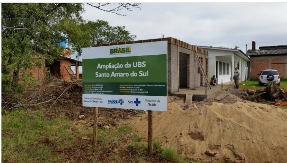
Placa da obra Data da última atualização: 11/08/2014
